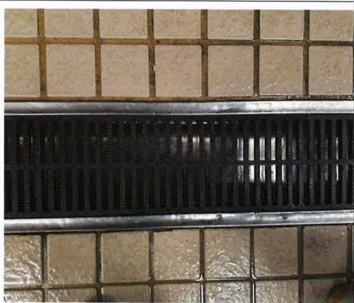
排水溝加蓋且乾淨
