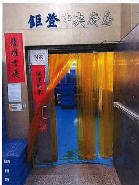
進廠房前設有防蚊簾(但未確實關閉)
