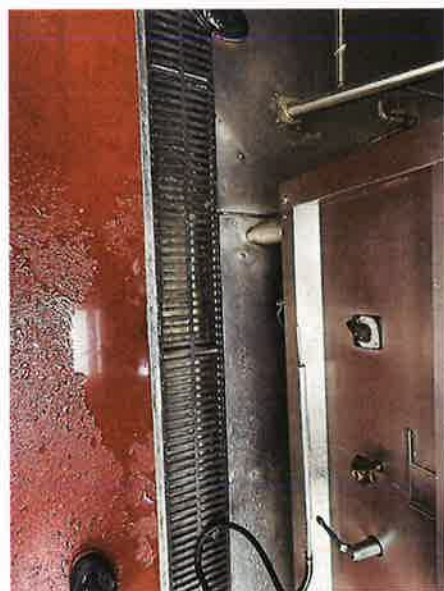
排水溝加蓋且乾淨
