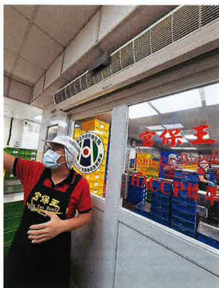
設有空氣簾防止病媒蚊飛入作業區
