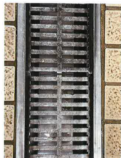
排水溝加蓋且乾淨
