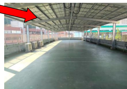
4. 明德樓風雨操場沒有老師帶領勿進入
